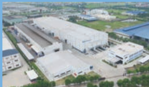
ベトナム新ポンプ工場 全景
